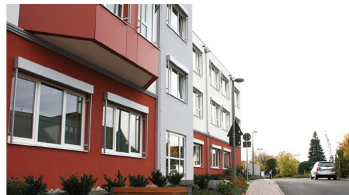
Neubau aus dem Jahr 2012 mit Notaufnahme, Intensivstation und Bettenstationen in Stock 1 und 2
