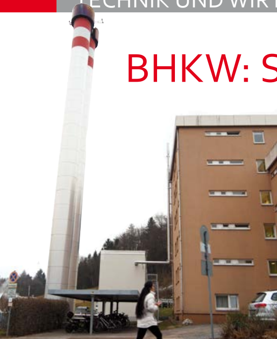
Von außen unscheinbar: Neues Blockheizkraftwerk (Bildmitte)
